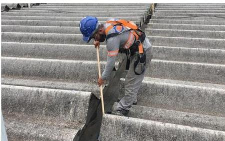
Além da limpeza das calhas (foto) e da troca de calhetas, a manutenção no telhado do MLP também envolve a substituição das placas metálicas
